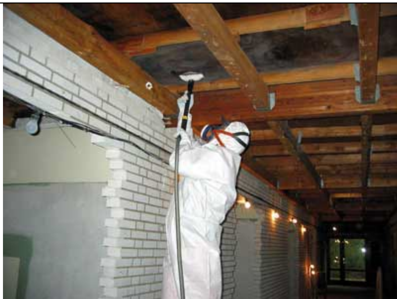
Dampafrensning med tør damp
